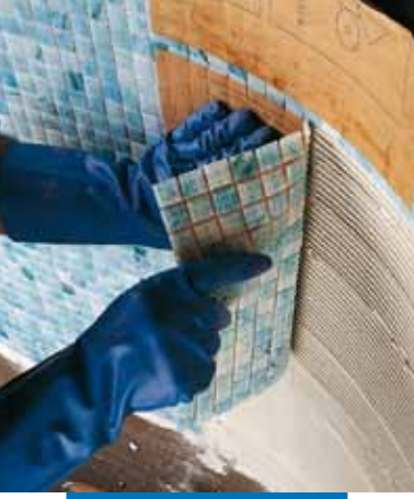
Bir yüzme havuzunda 2x2 cm cam mozaiklerin 1:1 oranında seyreltilmiş Isolastic ve Adesilex P10 karışımı ile uygulanması
