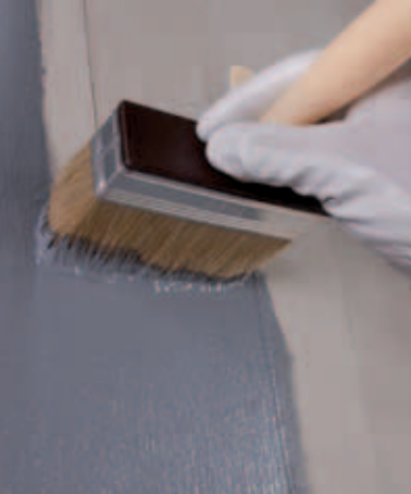
Beton üzerine fırça ile Eco Prim Grip uygulanması
