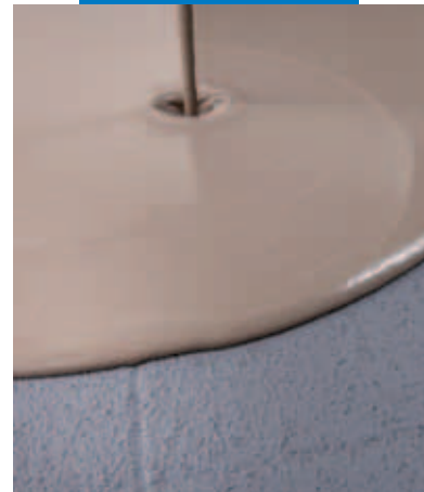
Eski bir zemin üzerindeki kuru Eco Prim Grip üzerine kendiliğinden yayılan tesviye bileşeni Ultraplan uygulanması
