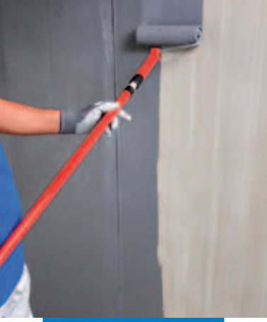
Beton üzerine rulo ile Eco Prim Grip uygulanması
