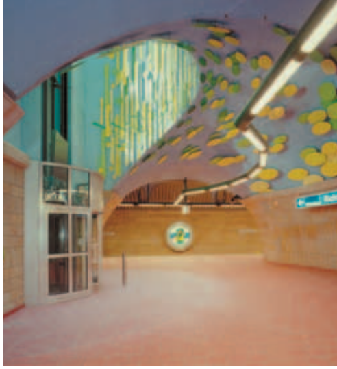
Granirapid ile yapılmış bir granit uygulaması örneği Mulheim Ruhr (Almanya)'da bir metro istasyonu
