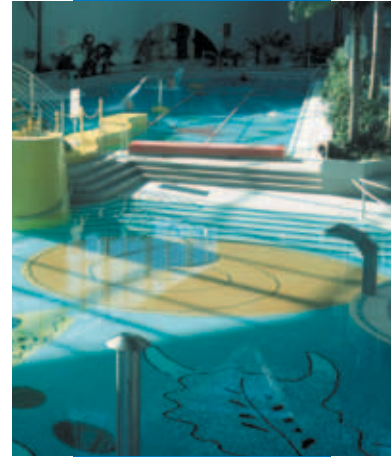
Bir yüzme havuzunda uygulanmış mozaik ve klinker örneği
