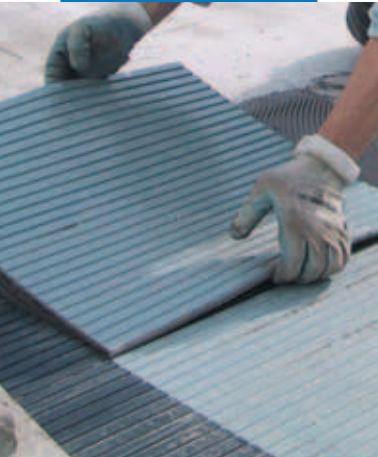
Kauçuk zemin döşemesinin, çimento üzerine Granirapid ile uygulanması
