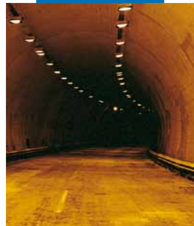
Otoyol tüneline Idrosilex Pronto'nun püskürtme tabancasıyla uygulanması
