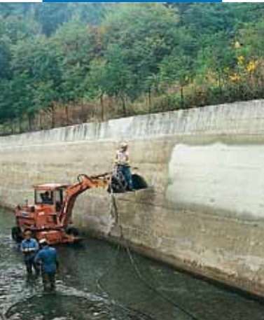
Bir hidroelektrik kanalda Idrosilex Pronto'nun püskürtme tabancasıyla uygulanması
