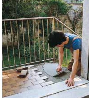
Kerabond T + Isolastic ile su yalıtımı, tesviye ve döşeme yapılması
