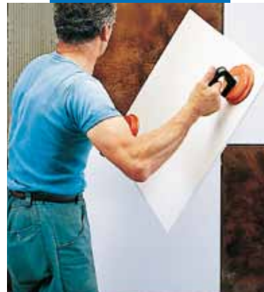
Bir duvara KERAION cephe sistemi döşenmesi
