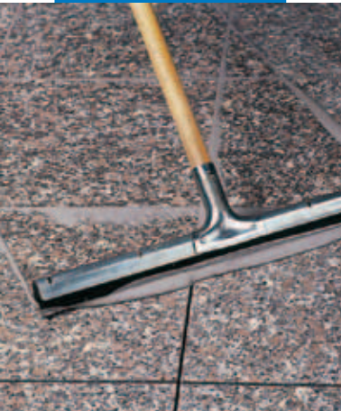
Önceden cilalanmış, parlatılmış granit kaplamanın derz dolgusunun kauçuk çekpas ile yapılması
