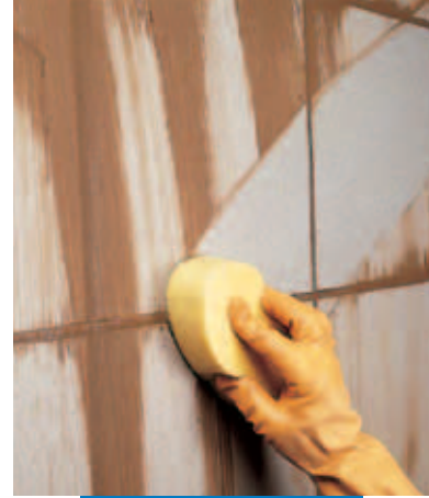
Süngerle bitirme işlemi uygulanan bir duvar
