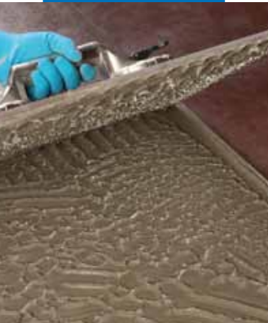
Karoların arka yüzünde kaplama miktarının kontrol edilmesi
