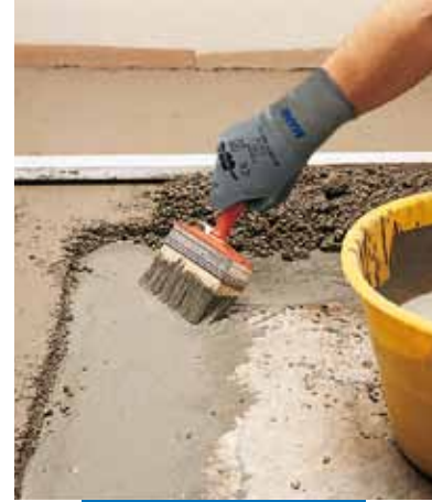
Monolitik Mapecem şapları için ankraj şerbetinin yayılması
