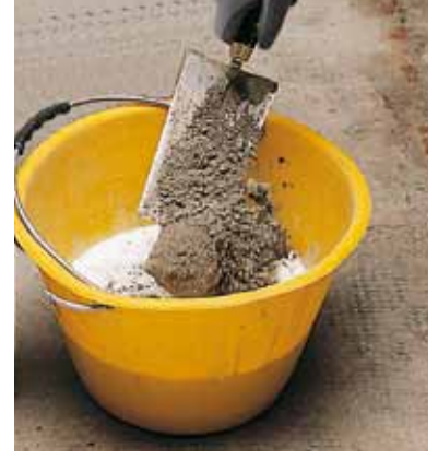
Mapecem'in ankraj şerbeti yapmak için Planicrete ile karıştırılması
