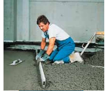
Düz kenarlı mastarın kullanılması
