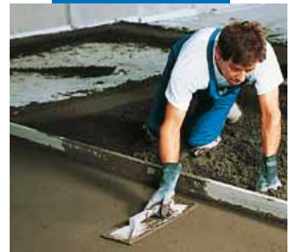
Mapecem şapın düzeltilmesi
