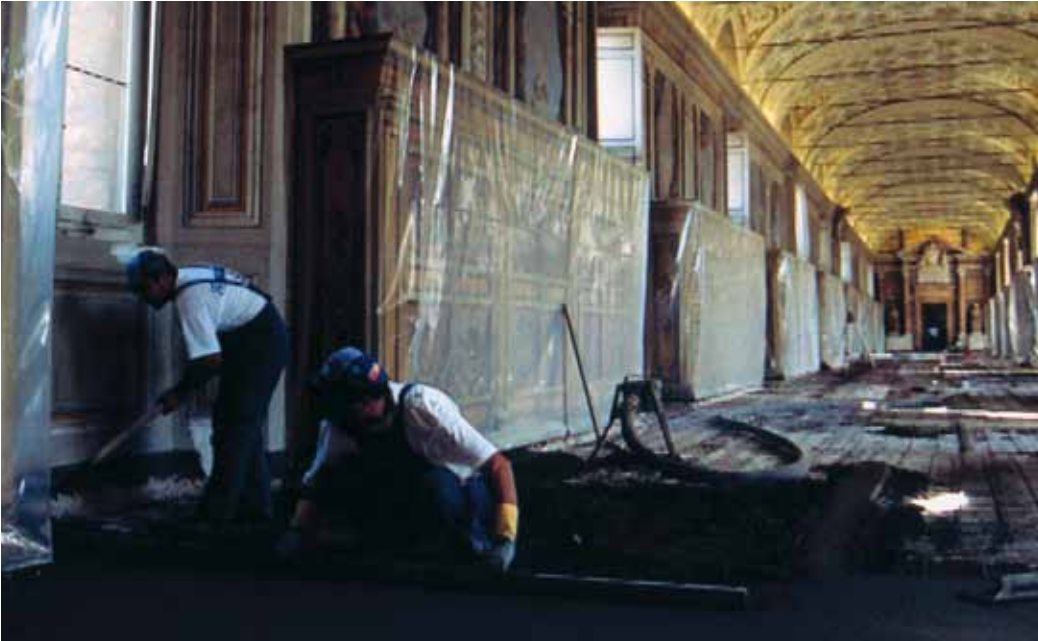
Mapecem şapın dökülmesi ve tesviye edilmesi - Sistine Halls - Vatikan
