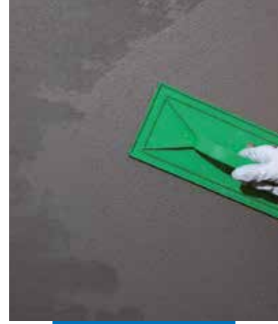
Mapegrout 430'un bitirilmesi
