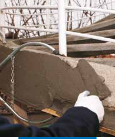
Mapegrout 430'un malayla uygulanması
