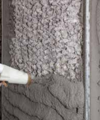
Mapegrout 430'un püskürtmeyle uygulanması
