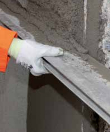
Mapegrout 430'un düz kenarlı mastarla tesviyesi
