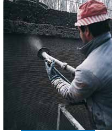
Bertini hidroelektrik kanalı - Robbiate (Como) - İtalya: püskürtme uygulama
