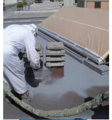
Bitümlü membran üzerine Purtop 400 M uygulanması
