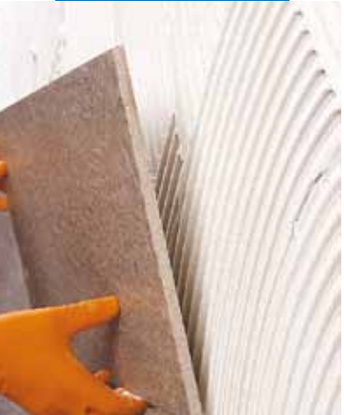
Geniş boyutlu, çift pişirilmiş karoların duvarda, yukarıdan başlanarak aşağı doğru döşenmesi
