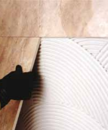
Geniş boyutlu porselen karoların duvara döşenmesi
