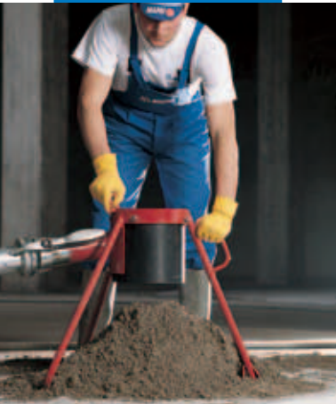
Topcem karışımının hazırlanması
