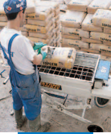
Topcem'in mini harç makinesinde karıştırılması
