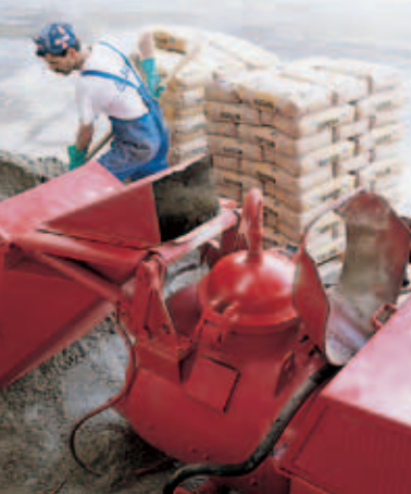
Topcem'in otomatik pompa ünitesinde karıştırılması
