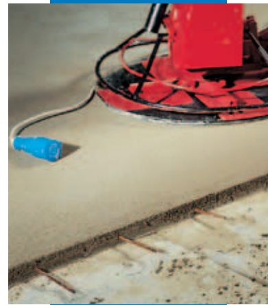
Topcem şapın yüzeyinin perdah makinesi ile düzeltilmesi
