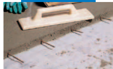
Demir donatı yerleştirilmiş Topcem şap detayı
