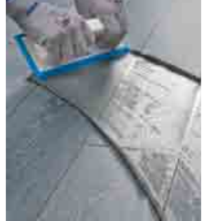
Ultracolor Plus'ın ahşap efektli porselen karolar üzerine kauçuk mala ile yayılması
