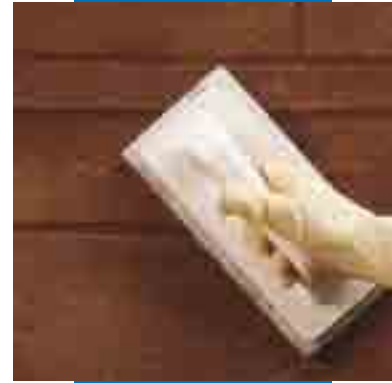
Derzlerin Scotch-Brite® ile temizlenmesi (ürün kısmen kurduğunda)
