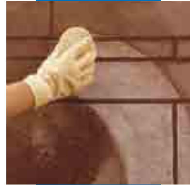
Derzlerin bir süngerle temizlenmesi ve bitirilmesi
