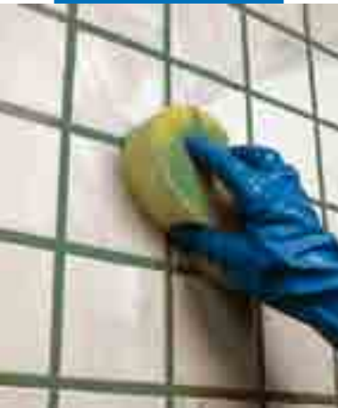
Bir duvardaki derzlerde süngerle yapılan temizlik ve bitirme işlemi
