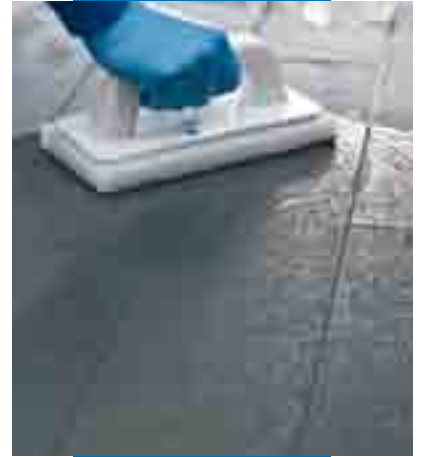
Derzlerin (Ürün yarı sertleşmişken) Scotch-Brite sünger ile temizlenmesi
