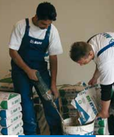
Ultraplan Eco'nun karıştırılması - Mirabello anaokulu - Cantù (Como) - İtalya
