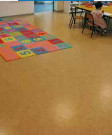
Ultraplan Eco ile önceden tesviye edilmiş şap üzerine linolyum uygulaması - Mirabello anaokulu - Cantù (Como) - İtalya
