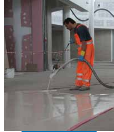
Ultratop'un mekanik olarak uygulanması
