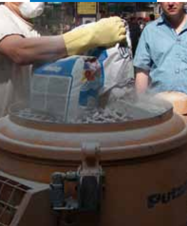
Ultratop'un bir mikserde hazırlanması
