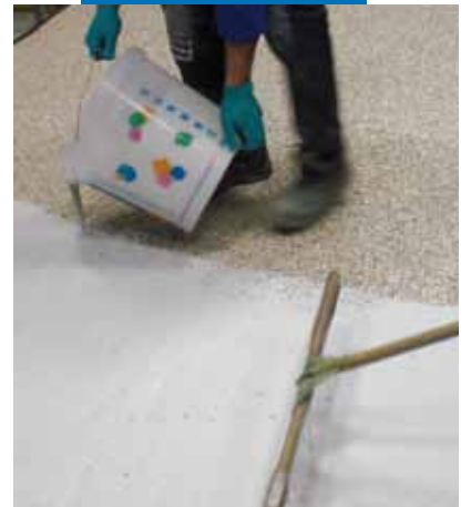
Doğal agregalar + Mapefloor I 910 karışımı ile yapılmış, sertleşmiş yüzey üzerine Ultratop uygulaması
