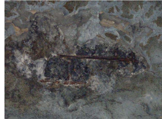
Şekil 2. Korozyon sonucu dökülmüş kabuk betonları
