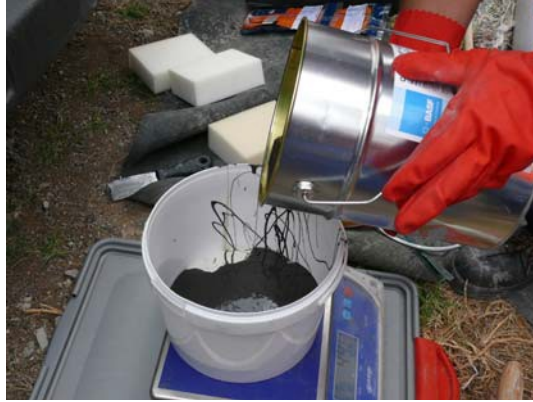
Şekil 9. B Bileşenin ölçülerek A bileşeni içerisine eklenmesi ve karıştırılarak astarın hazırlanması
