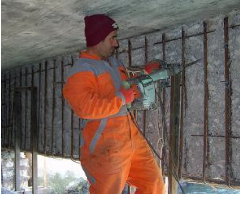
Şekil 19. Ayrışmış betonların kırılarak sağlam betonun açığa çıkarılması
