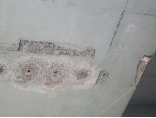
Şekil 1. Yetersiz su yalıtımı sonucunda küflenmiş ve dökülen beton örtüsü
