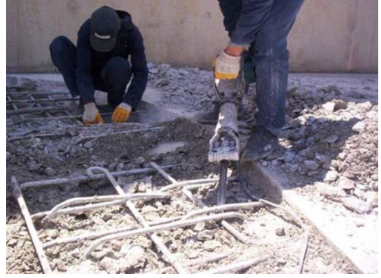
Şekil 19. Ayrışmış betonların kırılarak sağlam betonun açığa çıkarılması
