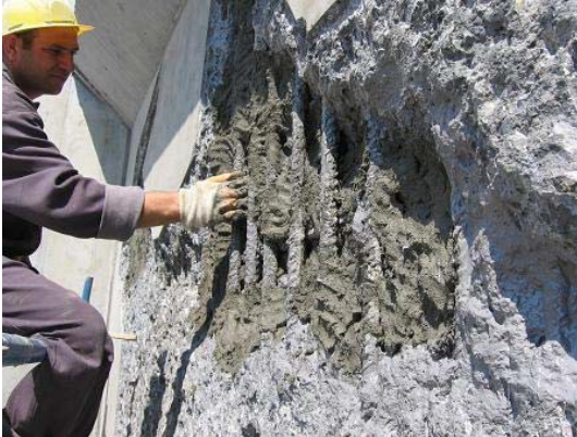
Şekil 24. Tamir harcının astarlanmış yüzeylere el ile uygulanması
