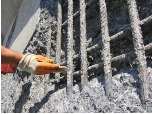
Şekil 23. Temizlenmiş yüzeylerin ve donatıların Concresive® 1420 ile astarlanması
