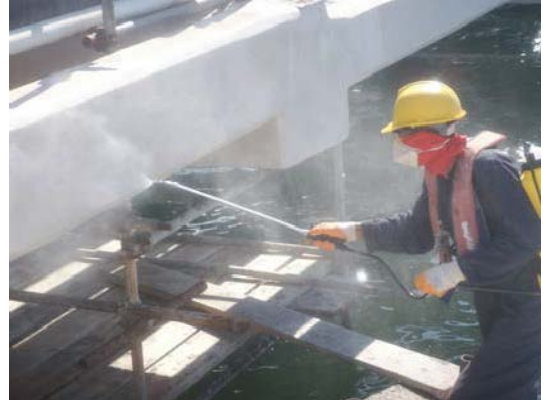
Şekil 26. Beton yüzeylerde silan esaslı su itici malzeme ile yüzey koruma uygulaması
