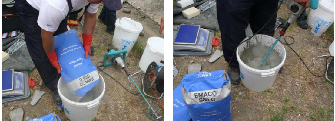
Şekil 12. Tamir harcının karıştırılması
