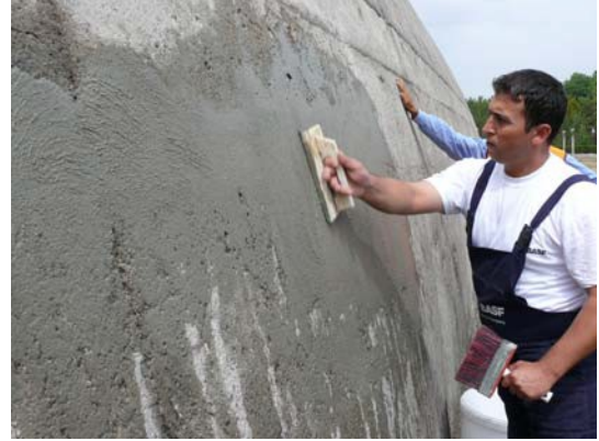
Şekil 15. Uygulamadan tamir harcının yüzeyinin ıslatılması ve tahta mala ile perdahlanması.
