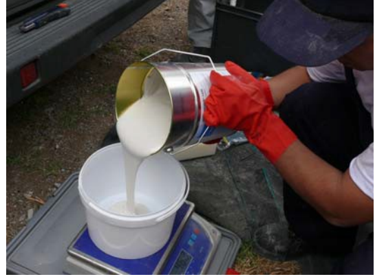
Şekil 8. Concrese® 1420 malzemesinin karışım öncesi karıştırma oranlarına göre tartılarak ölçülmesi
