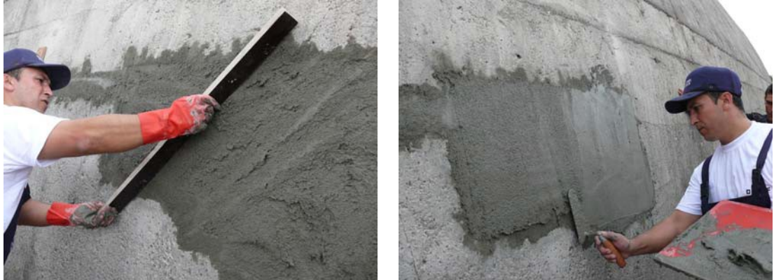
Şekil 14. Tamir harcının mastar ile tesviye edilmesi ve çelik mala ile yüzeyin ilk düzeltmesinin yapılması.
