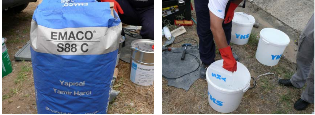
Şekil 11. Tamir harcı karıştırmak için gerekli olan su miktarının ölçülerek temiz bir karıştırma kovaasına konulması
