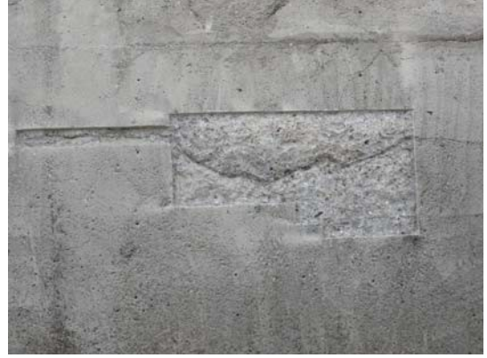
Şekil 5. Ayrışmış betonların kırılarak sağlam betonun açığa çıkarılması
