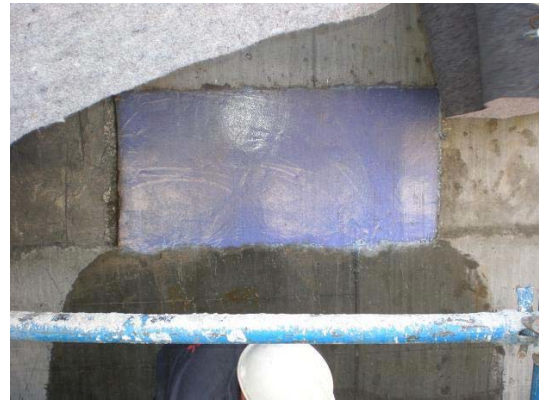
Şekil 17. Masterkure 101 kullanılarak kürlenmesi
