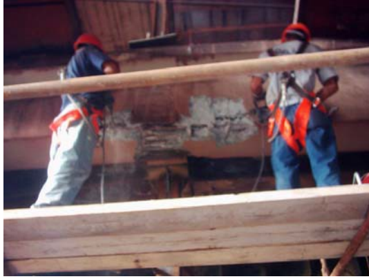
Şekil 5. Ayrışmış betonların kırılarak sağlam betonun açığa çıkarılması
