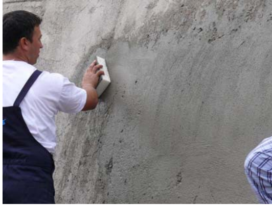
Şekil 16. Perdahlanmış yüzeyin sert sıvacı sünger ile son bitişinin yapılması
