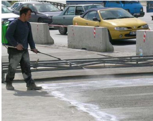
Şekil 17. Masterkure 101 kullanılarak kürlenmesi
