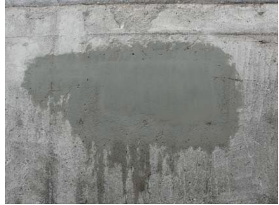
Şekil 16. Perdahlanmış yüzeyin sert sıvacı sünger ile son bitişinin yapılması
