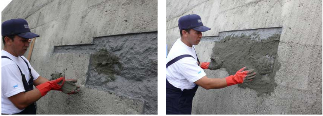
Şekil 13. Tamir harcının astarlanmış yüzeylere el ile uygulanması
