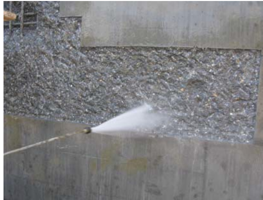
Şekil 7. Kırım işlemi tamamlanmış yüzeylerin temizlenmesi
