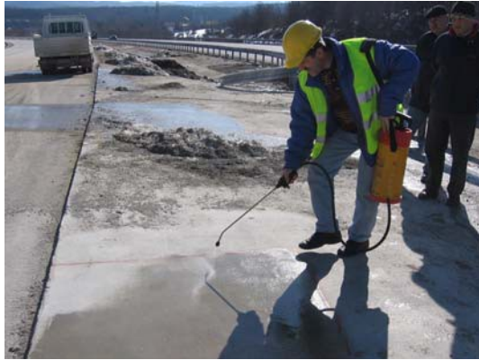
Şekil 26. Beton yüzeylerde silan esaslı su itici malzeme ile yüzey koruma uygulaması
