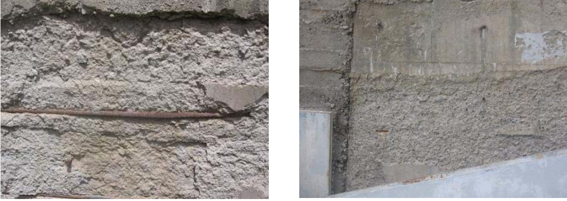
Şekil 2a. Donma - çözünme etkileri sonucunda aşınmış beton yüzeyler
