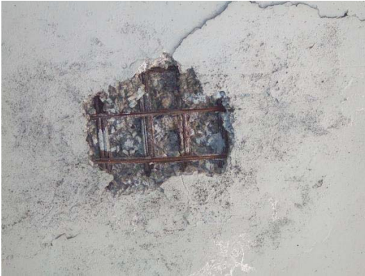
Şekil 2. Korozyon sonucu dökülmüş kabuk betonları
