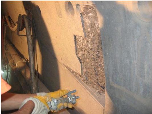
Şekil 7. Kırım işlemi tamamlanmış yüzeylerin temizlenmesi
