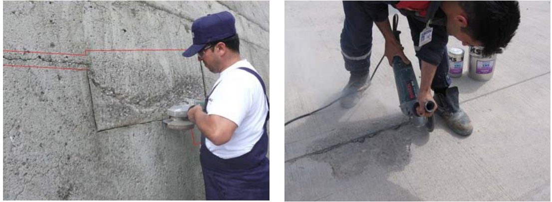
Şekil 4. Onarım öncesi işaretlenmiş bölgelerin kesilmesi
