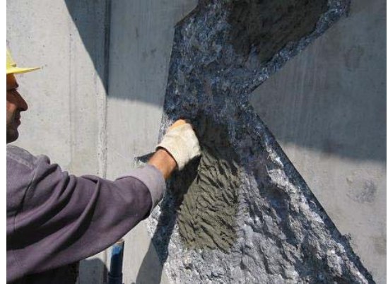
Şekil 24. Tamir harcının astarlanmış yüzeylere el ile uygulanması
