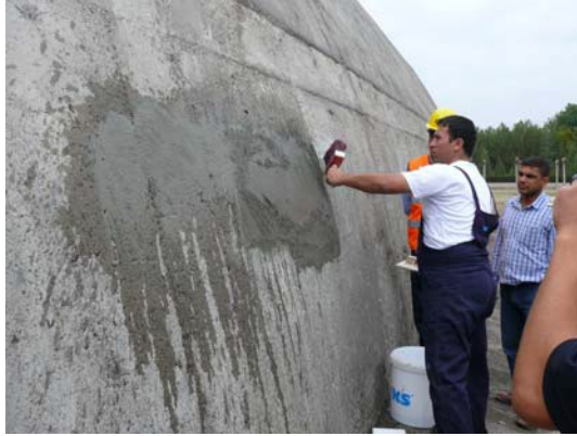
Şekil 15. Uygulamadan tamir harcının yüzeyinin ıslatılması ve tahta mala ile perdahlanması.
