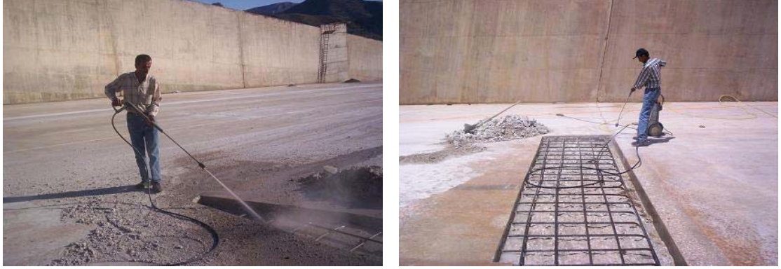
Şekil 22. Kırım işlemi tamamlanmış yüzeylerin temizlenmesi
