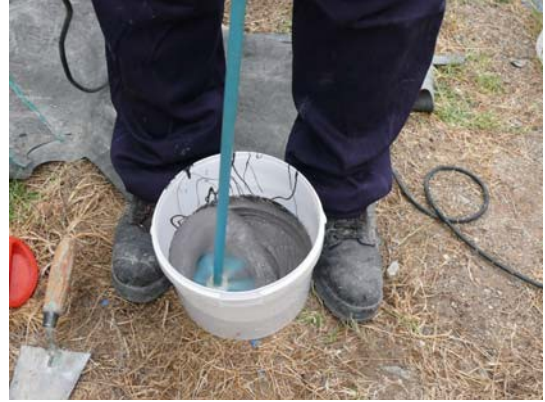
Şekil 9. B Bileşenin ölçülerek A bileşeni içerisine eklenmesi ve karıştırılarak astarın hazırlanması
