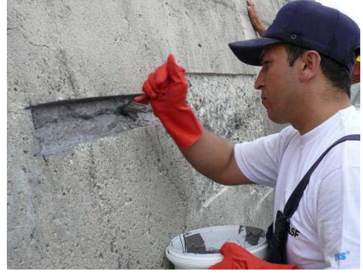
Şekil 23. Temizlenmiş yüzeylerin ve donatıların Concresive® 1420 ile astarlanması
