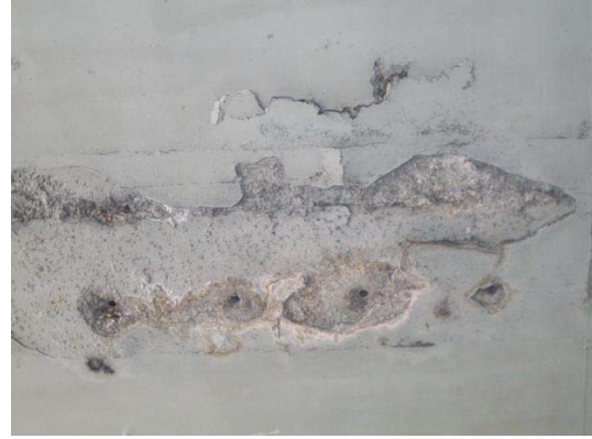
Şekil 1. Yetersiz su yalıtımı sonucunda küflenmiş ve dökülen beton örtüsü
