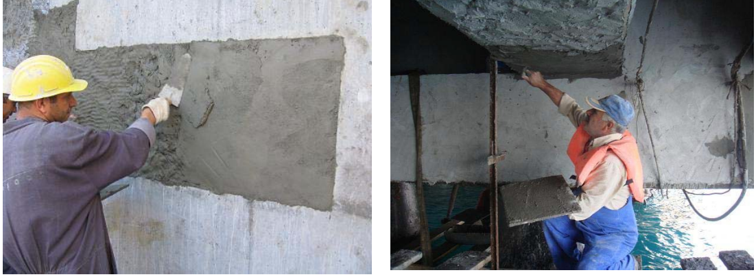
Şekil 25. Tamir harcının master ile tesviye edilmesi ve çelik mala ile yüzeyin ilk düzeltilmesinin yapılması.
