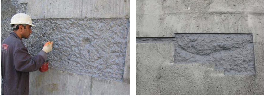
Şekil 10. Temizlenmiş yüzeylerin Concrecive® 1420 ile astarlanması
