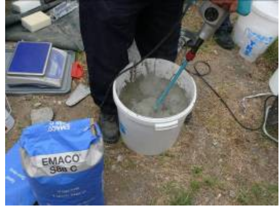
Şekil 10. Tamir harcının karıştırılması
