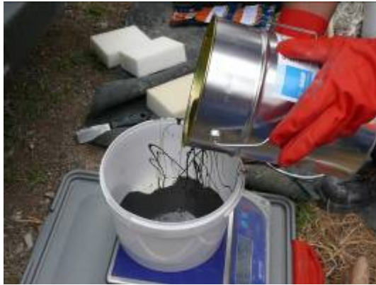
Şekil 7. B Bileşeninin ölçülerek A bileşeni içerisine eklenmesi ve karıştırılarak astarın hazırlanması
