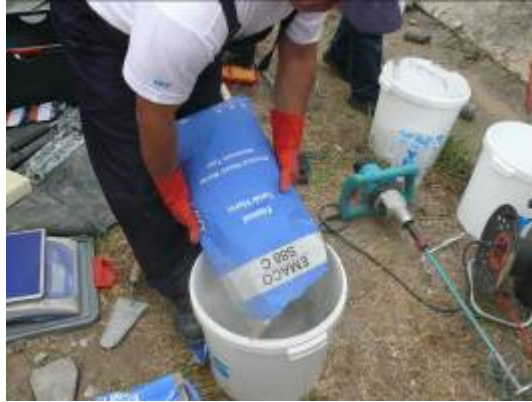
Şekil 10. Tamir harcının karıştırılması
