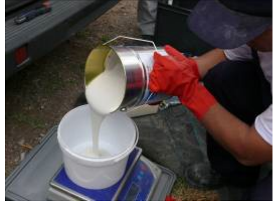
Şekil 6. Concresive® 1420 malzemesinin karışım öncesi karıştırma oranlarına göre tartılarak ölçülmesi
