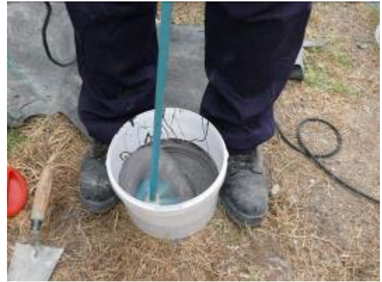
Şekil 7. B Bileşeninin ölçülerek A bileşeni içerisine eklenmesi ve karıştırılarak astarın hazırlanması
