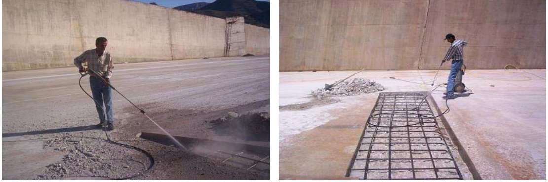
Şekil 5. Kırım işlemi tamamlanmış yüzeylerin temizlenmesi
