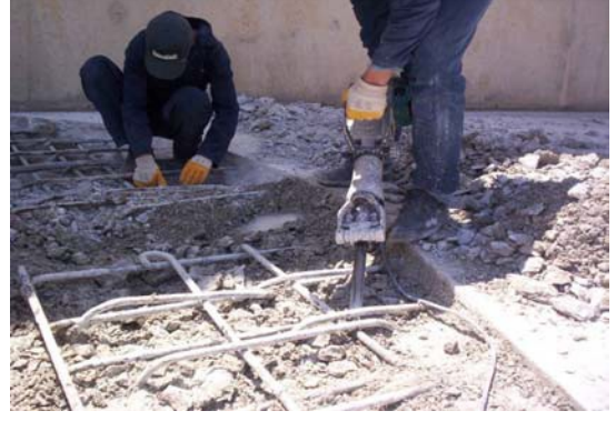
Şekil 2. Ayırılmış betonların kırılarak sağlam betonun açığa çıkarılması
