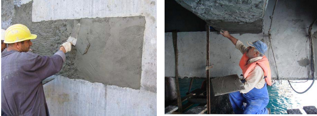
Şekil 12. Tamir harcının mastar ile tesviye edilmesi ve çelik mala ile yüzeyin ilk düzeltilmesinin yapılması.
