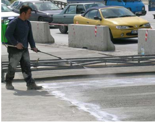
Şekil 13. a) Masterkure 101 kullanılarak kütleme yapılması. b) Islak keçeler ile tamir harcının korunması ve rüzgarlı havalarda naylon örtüler ile önlem alınması
