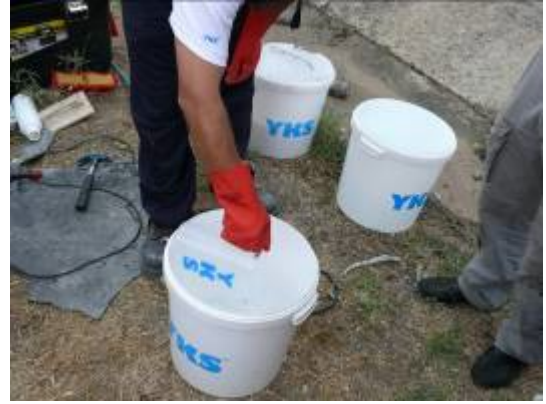
Şekil 9. Tamir harcı karıştırmak için gerekli olan su miktarının ölçülerek temiz bir karıştırma kovaasına konulması
