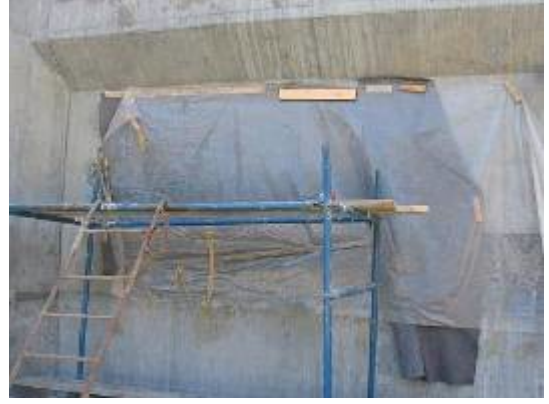
Şekil 13. a) Masterkure 101 kullanılarak kütleme yapılması. b) Islak keçeler ile tamir harcının korunması ve rüzgarlı havalarda naylon örtüler ile önlem alınması
