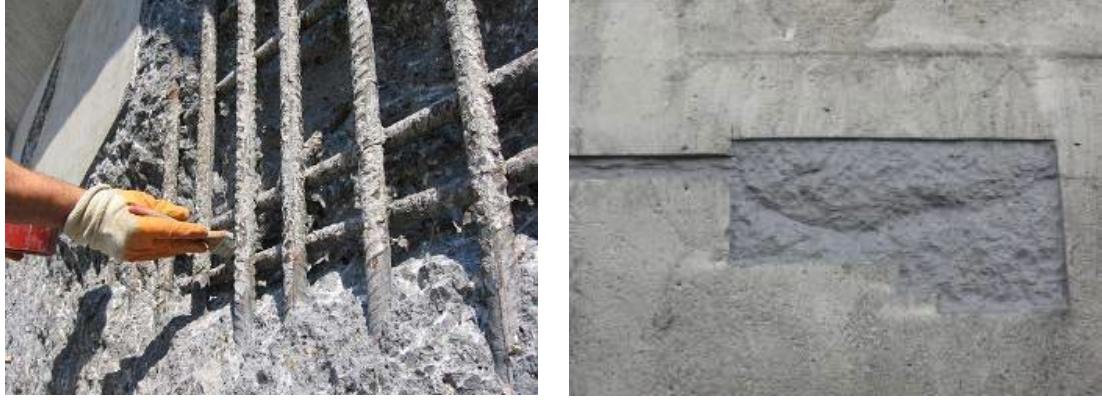
Şekil 8. Temizlenmiş yüzeylerin ve donatıların Concreative® 1420 ile astarlanması
