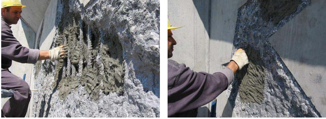
Şekil 11. Tamir harcının astarlanmış yüzeylere el ile uygulanması
