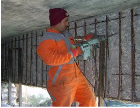
Şekil 2. Ayırılmış betonların kırılarak sağlam betonun açığa çıkarılması
