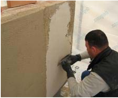
Şekil 8. ALBARIA™ STABILITURA uygulaması
