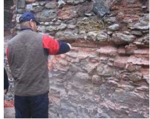
Şekil 9. Duvar hasarları ve basınçlı hava ile duvar yüzeyinde temizlik
