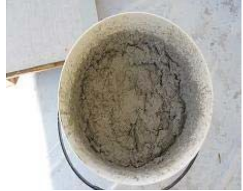
Şekil 10. ALBARIA™ ALLETTAMENTO'nun hazırlanması
