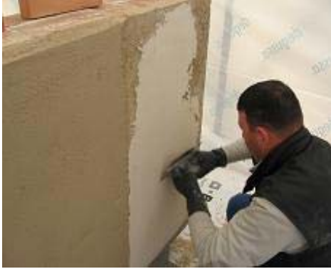
Şekil 17. ALBARIA™ STABILITURA uygulaması
