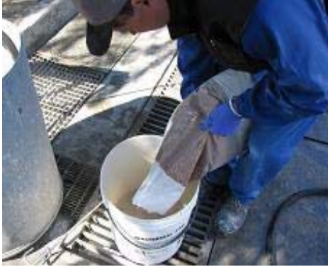
Şekil 10. ALBARIA™ ALLETTAMENTO'nun hazırlanması
