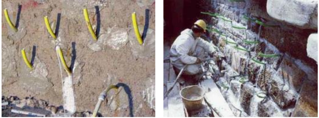
řekil 22. ALBARIA Iniezione enjeksiyonu ile duvarların g¼clendirilmesi
