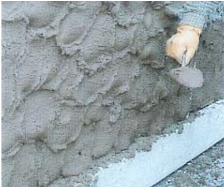
Şekil 15. ALBARIA™ INTONACO uygulaması
