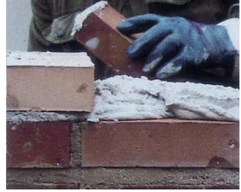
Şekil 11. ALBARIA™ ALLETTAMENTO ile duvar örülmesi
