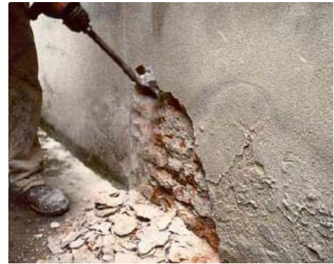
Şekil 12. Eski sıvanın kaldırılması
