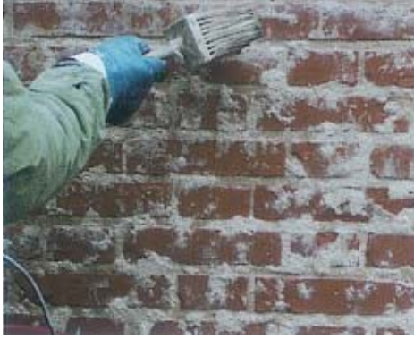
Şekil 14. Yüzeylerin ıslatılması ve serpme uygulaması
