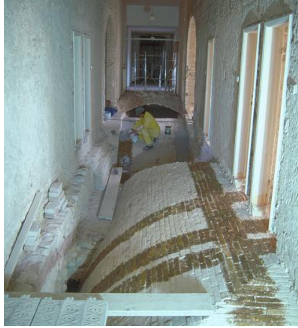
Şekil 23. Sıvası kaldırılan yüzeylerin Mbrace® Primer ile astarlanması
