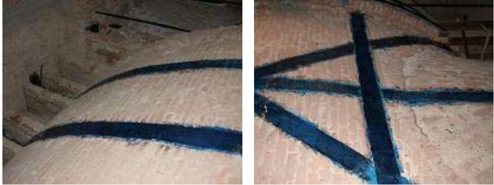
Şekil 26. Mbrace® Fiber ile tonozların güçlendirilmesi
