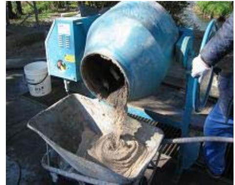
Şekil 13. ALBARIA™ INTONACO'nun hazırlanması
