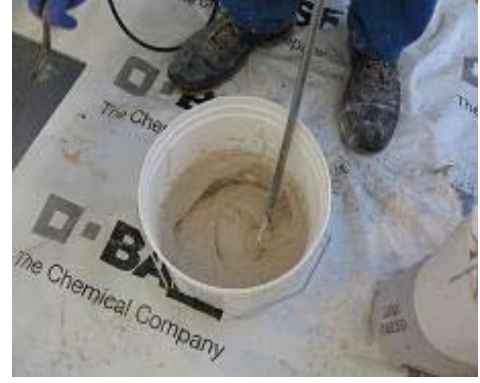
Şekil 16. ALBARIA™ STABILITURA'nın hazırlanması
