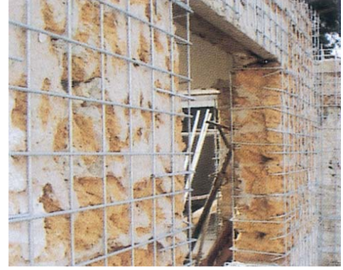
Şekil 2. Soyulan duvarlara çelik hasır yerleştirilmesi
