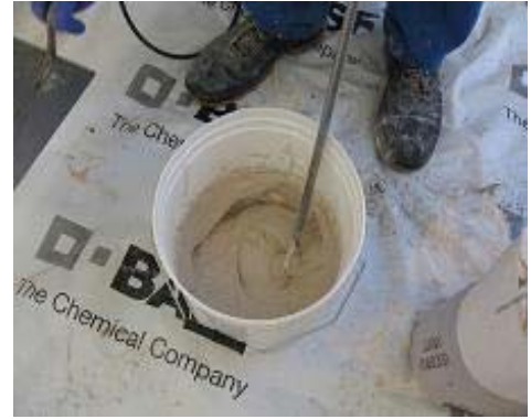
Şekil 7. ALBARIA™ STABILITURA'nın hazırlanması
