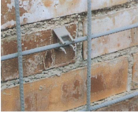
Şekil 2. Soyulan duvarlara çelik hasır yerleştirilmesi
