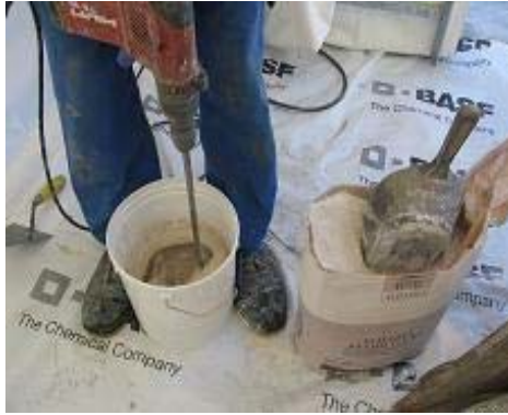
Şekil 7. ALBARIA™ STABILITURA'nın hazırlanması
