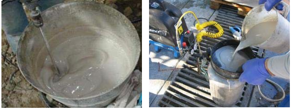
Şekil 20. Malzemenin hazırlanması ve enjeksiyon pompasına doldurulması
