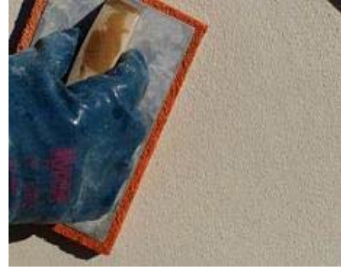
Şekil 17. ALBARIA™ STABILITURA uygulaması
