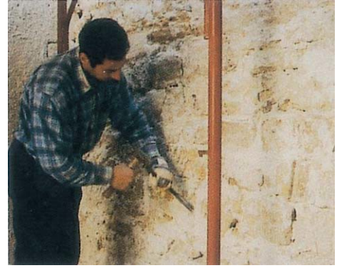
Şekil 1. Eski sıvanın kaldırılması
