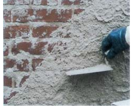
Şekil 14. Yüzeylerin ıslatılması ve serpme uygulaması
