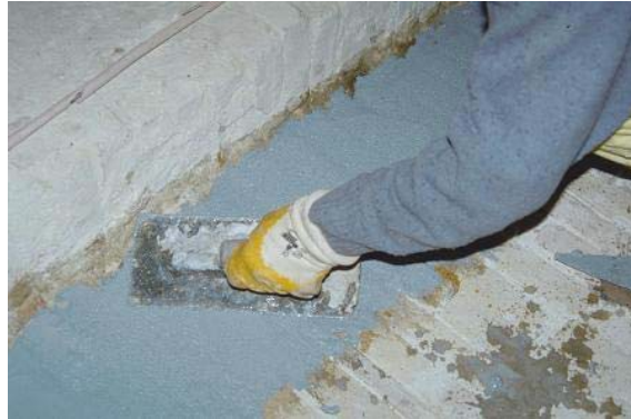
Şekil 24. Astarlanan yüzeylerin Concreative® 1406 ile düzeltilmesi
