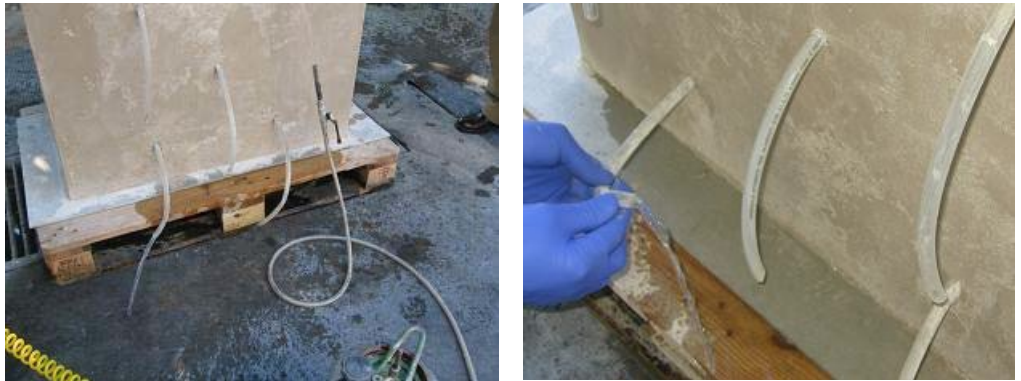
Şekil 21. Enjeksiyon öncesi çatlaklara su enjekte edilerek temizlik yapılması
