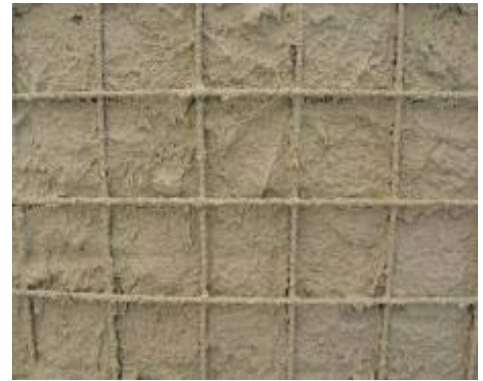
Şekil 4. Serpme uygulaması
