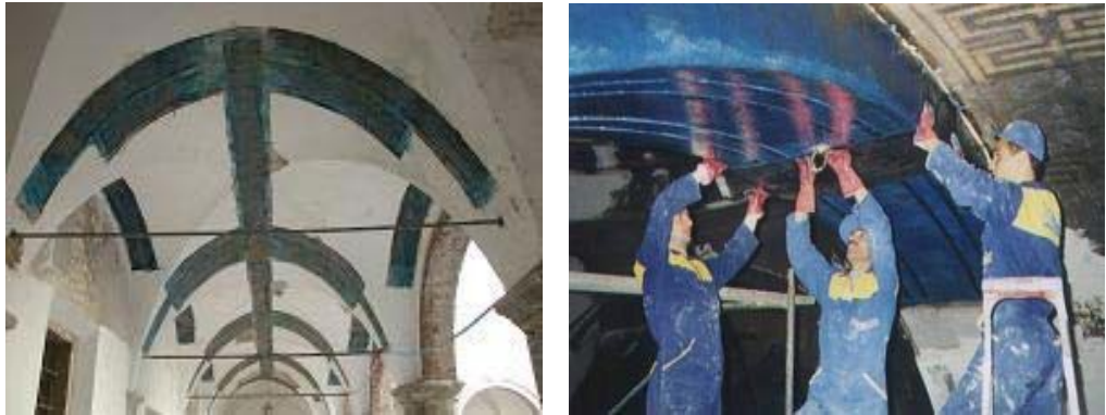
Şekil 27. Mbrace® Fiber ile kemerlerin güçlendirilmesi
