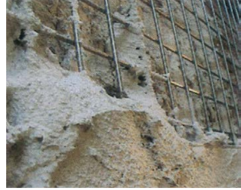
Şekil 5. Mantolama katının uygulanması
