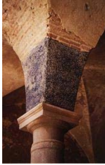
Şekil 28. Mbrace® Fiber ile pandatif ayaklarının güçlendirilmesi
