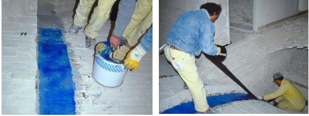
Şekil 25. Mbrace® Adesivo Saturant (yapıştırıcı) uygulaması ve Mbrace® Fiber yapıştırılması.
