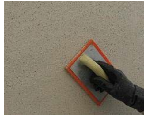
Şekil 6. Yüzeyin düzeltilmesi
