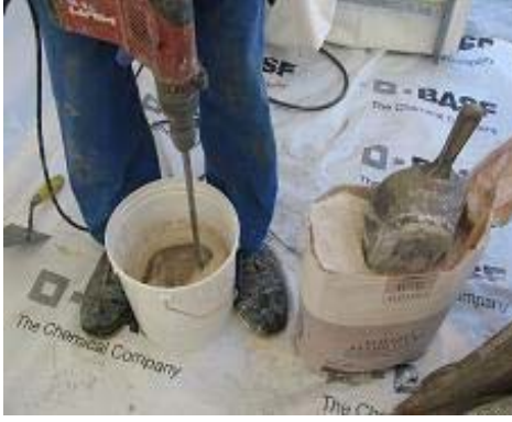
Şekil 16. ALBARIA™ STABILITURA'nın hazırlanması
