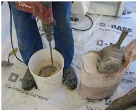
Şekil 5. ALBARIA™ STABILITURA'nın hazırlanması
