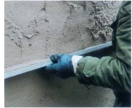
Şekil 4. ALBARIA™ INTONACO uygulaması
