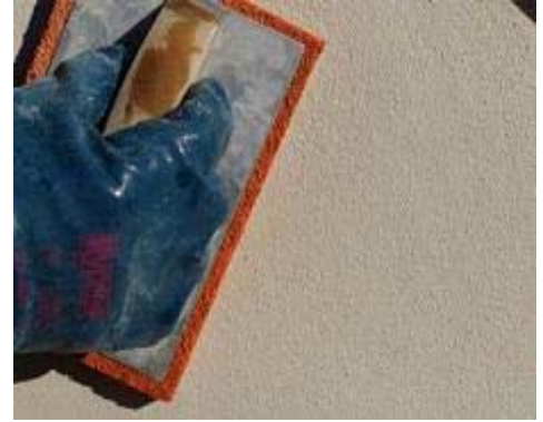
Şekil 6. ALBARIA™ STABILITURA uygulaması
