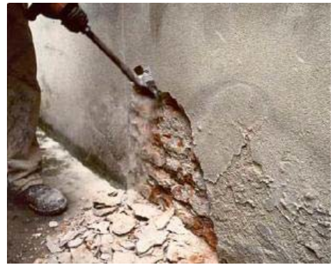
Şekil 1. Eski sıvanın kaldırılması
