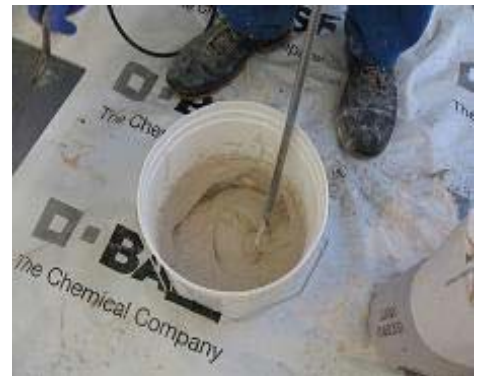
Şekil 5. ALBARIA™ STABILITURA'nın hazırlanması
