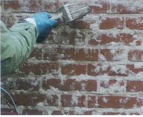
Şekil 3. Yüzeylerin ıslatılması ve serpme uygulaması
