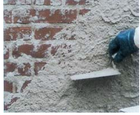
Şekil 3. Yüzeylerin ıslatılması ve serpme uygulaması
