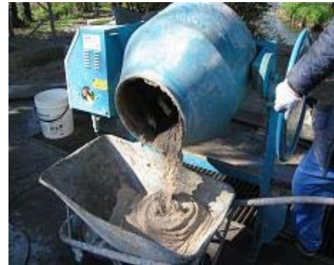
Şekil 2. ALBARIA™ INTONACO'nun hazırlanması
