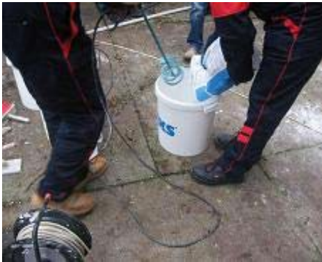
Şekil 2. ALBARIA™ INTONACO'nun hazırlanması
