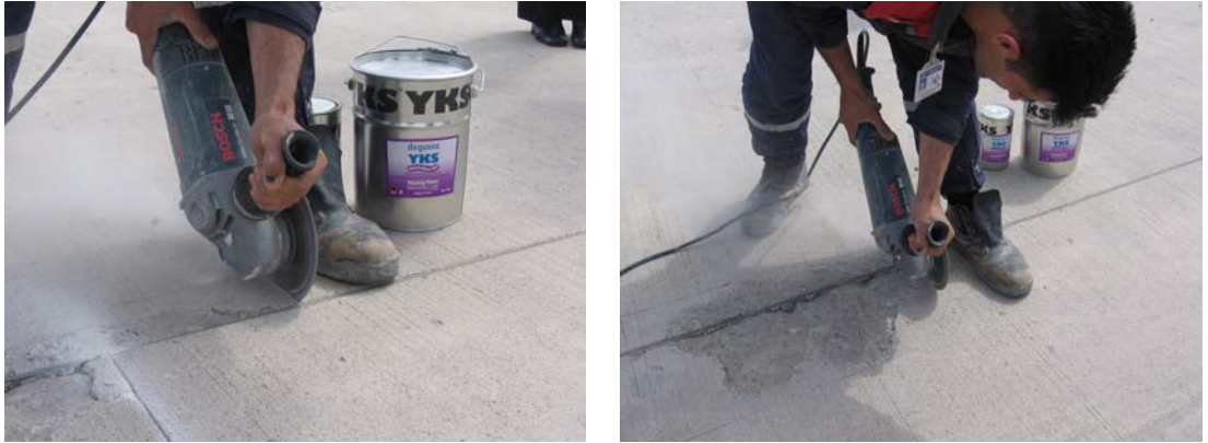
Şekil 4. Onarım öncesi işaretlenmiş bölgelerin kesilmesi
