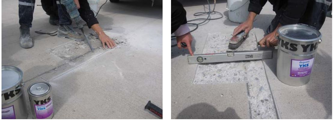
Şekil 5. Ayrılmış betonların kırılarak sağlam betonun açığa çıkarılması
