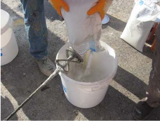
Şekil 8. Grout harcının karıştırılması
