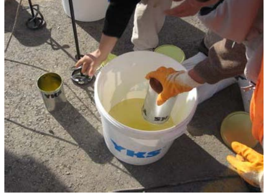
Şekil 7. Grout harcı A ve B bileşenlerinin temiz karıştırma kovasına konularak karıştırılması
