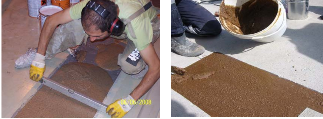
Şekil 9. Grout harcının yüzeye dökülerek uygulanması
