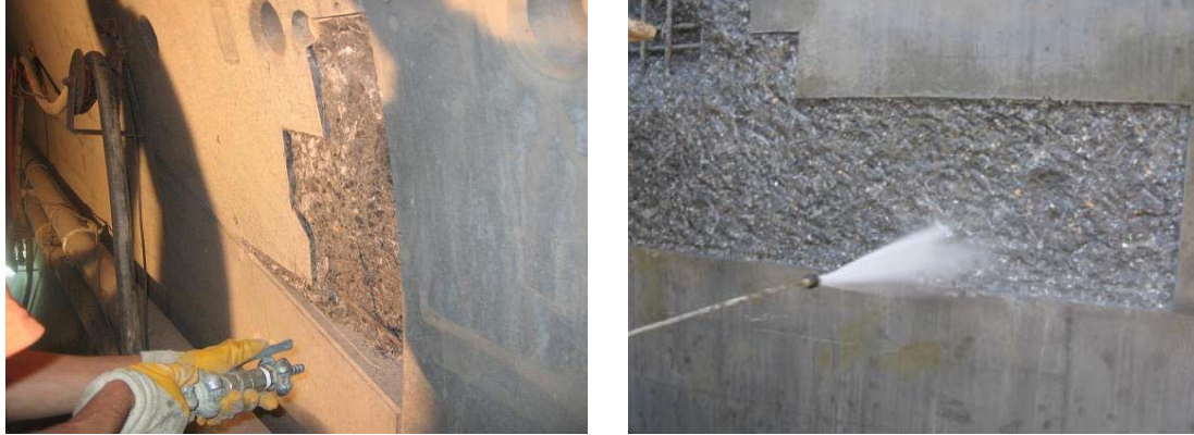
Şekil 6. Kırım işlemi tamamlanmış yüzeylerin temizlenmesi
