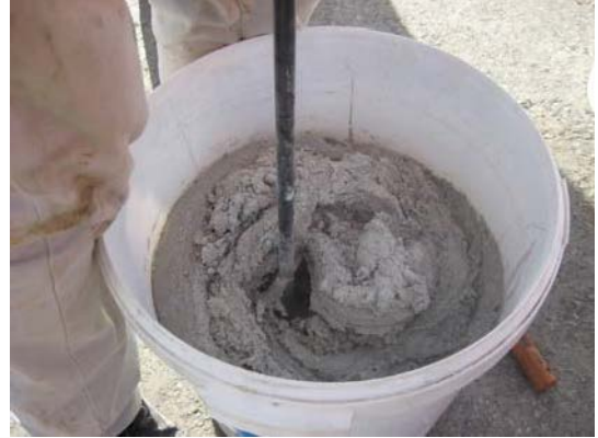
Şekil 8. Grout harcının karıştırılması
